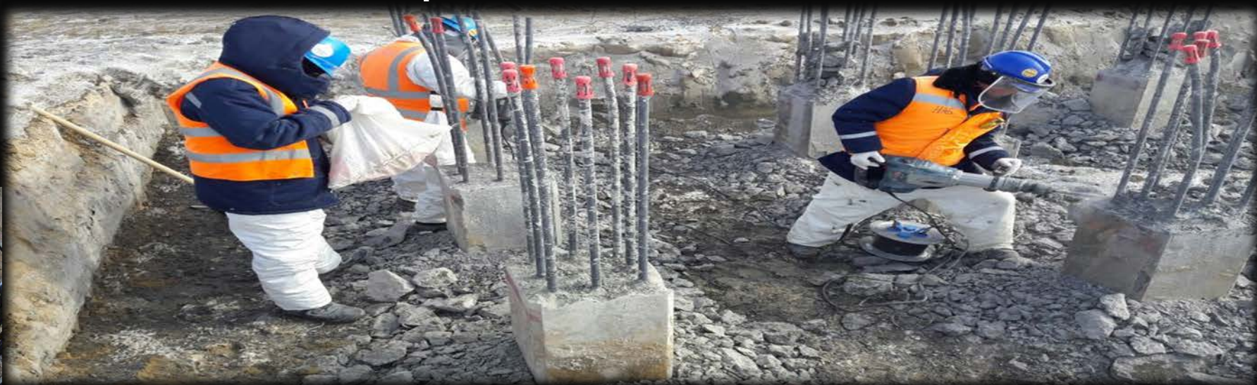
Крошитель оголовков свай 400*400 на 8 цилиндров – 5 шт.
