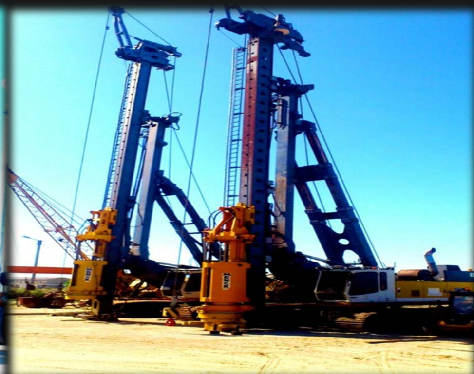
Гидравлический сваебойный агрегат LRB-150 на базе LIEBHERR HS843 HD/LRB-150
