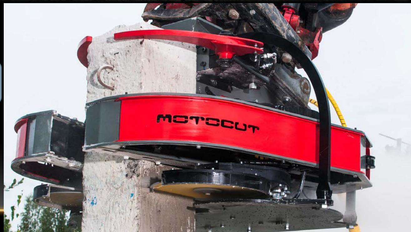
Механизированная срезка свай Мото Кат- 1 шт.
