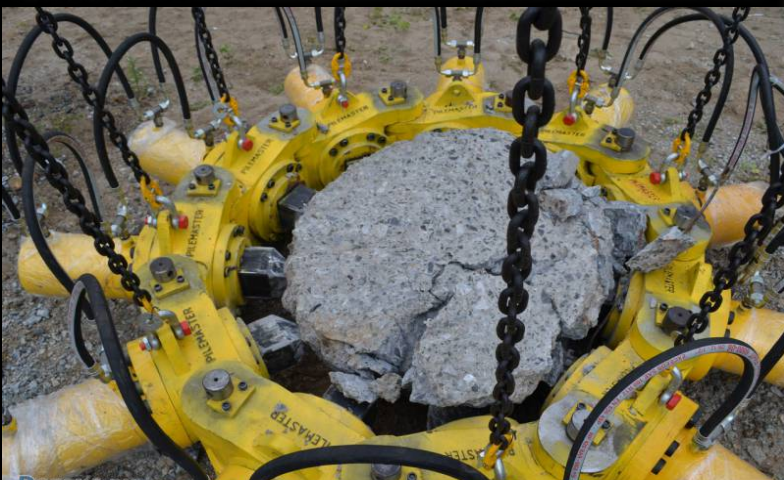
Крошитель оголовков буронабивных свай d до 630 мм – 1 шт.
