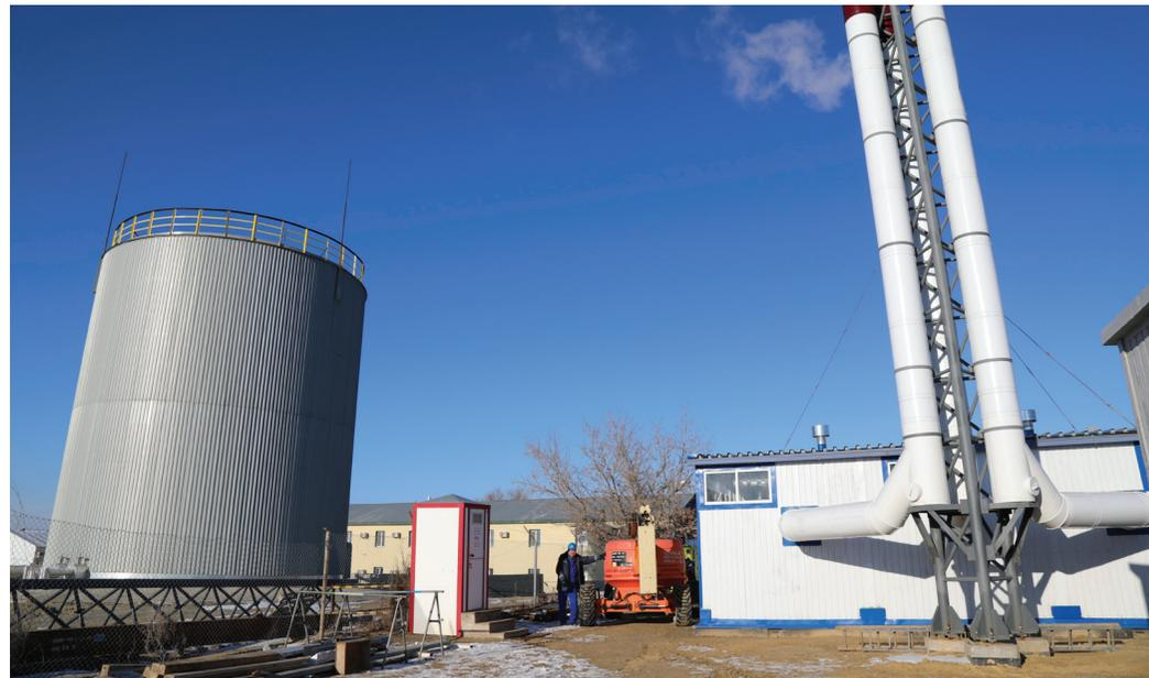
«Ариадна» построила близ микрорайона резервуар для запаса питьевой воды объемом 1000 м<sup>3</sup>, в настоящее время проектируется расширение блока водоснабжения до 3000 м<sup>3</sup>.
