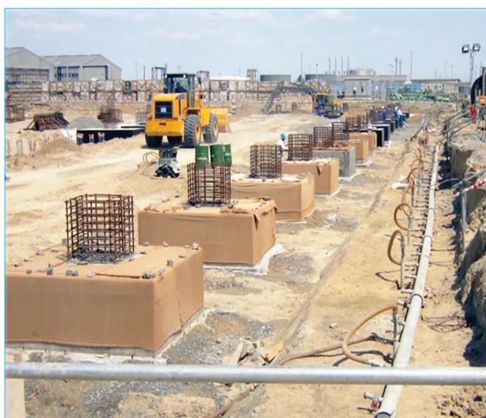
Во время фундаментных работ на складе 21/22 в основании было залито 1034, 80 кубических метров бетона.
