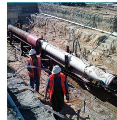
Построенный напорный трубопровод протяженностью 2 км. и 26 железобетонных колодцев.
