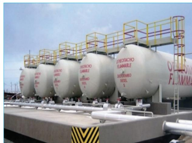
Произведены пескоструйная очистка, покраска и монтаж 16-ти емкостей объемом 200 м.3 и 5 емкостей 100 м3 на складе ГСМ.
