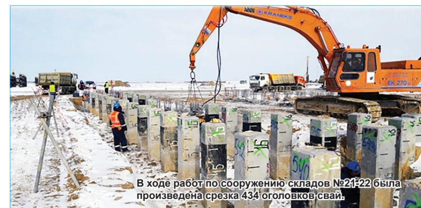
В ходе работ по сооружению складов №21-22 была произведена срезка 434 оголовков свай.
